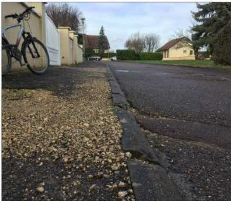
Pont un coût estimé à près de 62 000 € hors taxes, la réfection des bordures et trottoirs du lotissement Clair-Vallon sera réalisée au printemps. Photo LBP/S. T.
