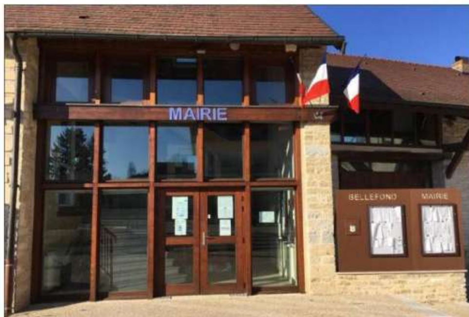
Quatre des treize caméras de vidéosurveillance seront installées sur la mairie : deux en façade avant, pointées sur l'esplanade et la place des écoles, deux en façade arrière, surveillant le parking et ses abords. Photo LBP/S. T.
