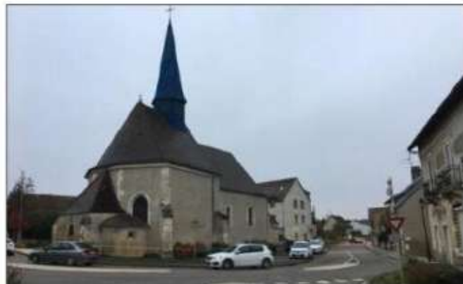
Le projet de vidéosurveillance prévoit l'installation de onze caméras dont, entre autres, au carrefour de l'église. Photo LBP/S. T.
