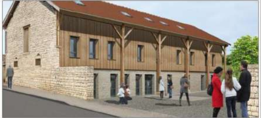
Au 4 de la rue de Ruffey, la municipalité de Bellefond va réhabiliter l'ancienne grange pour y construire 657 mètres carrés de logements et 81 mètres carrés de locaux techniques. Photo Visuel Chamoin-Melsens Architectes Associés
