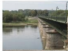
Le pont-canal métallique de Briare (France).
