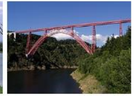
Le viaduc de Garabit situé près de Ruynes (France).
